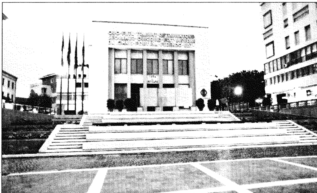
Piazza XX Settembre con il fabbricato che ospita la Casa del mutilato oggetto dell'esercitazione architettonica
